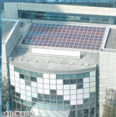
本社(横浜ビル)
