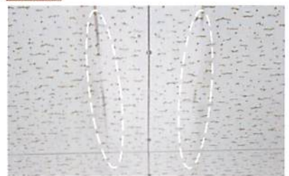
従来器具を取り外すと天井には器具跡が残っています。器具跡はリニューアル時の大きな問題点です。
