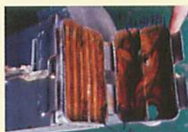
エアクーラ内部の切断状況
