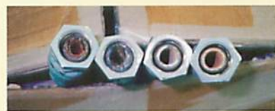
ラバーホース内面状況
